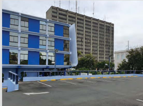
▲ RESTABLECIMIENTO DE LA CONTINUIDAD PEATONAL Y ESTÉTICA ORIGINAL. Se demolieron los anexos que invadían el espacio público y se eliminaron las verjas y jardineras, restableciendo la conexión peatonal. En la fachada se recuperó el lenguaje moderno mediante un sistema de fachadas ventiladas y la reposición de los cerramientos según su modulación original
