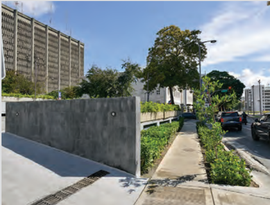
▲ RESTABLECIMIENTO DE LA CONTINUIDAD PEATONAL Y ESTÉTICA ORIGINAL. Se demolieron los anexos que invadían el espacio público y se eliminaron las verjas y jardineras, restableciendo la conexión peatonal. En la fachada se recuperó el lenguaje moderno mediante un sistema de fachadas ventiladas y la reposición de los cerramientos según su modulación original
