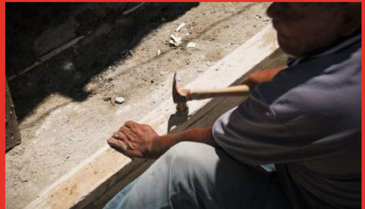
Préstamos Mejoramiento de Vivienda
